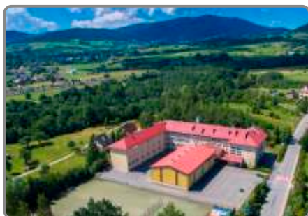
Kompleks budynków szkolnych w Słupnicach Dolnych
