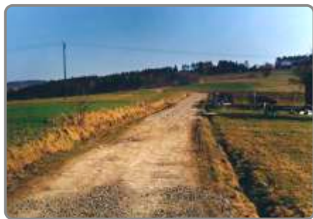
Droga w osiedlu Miłkowskie
