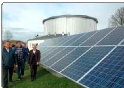
Instalacja fotowoltaiczna dla oczyszczalni
