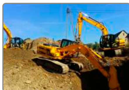
Budowa kanalizacji sanitarnej
