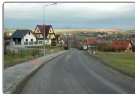
Chodnik i oświetlenie oraz nowa nawierzchnia w osiedlu Gieźniki Górne
