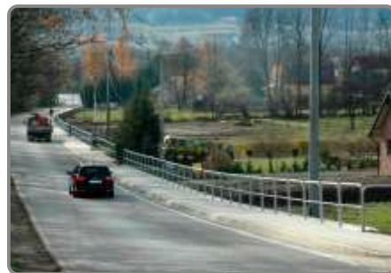
Odcinek chodnika przy drodze powiatowej w osiedlu Putówka
