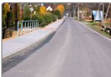
Chodniki i oświetlenie przy drodze powiatowej w Słopnicach Górnych
