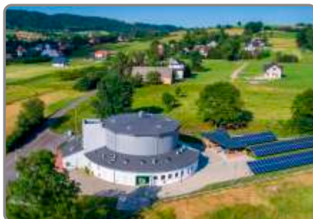
Oczyszczalnia ścieków w Słupnicach
