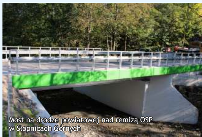
Prace remontowe na moście w Słopnicach Dolnych
